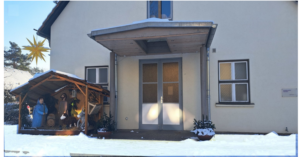
Ein neues Vordach für den Eingang unserer Kirche
